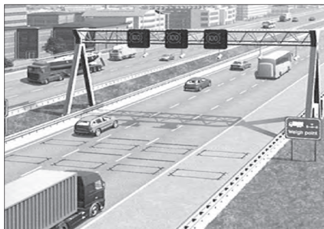
Obr. 3: Instalace ve všech dopravních pruzích
